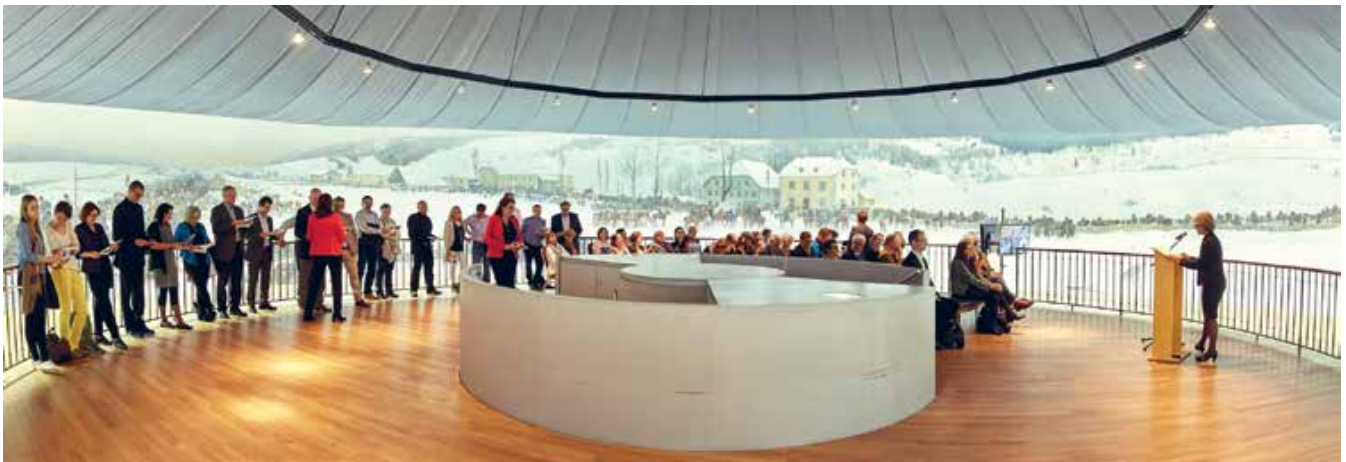
Raffinierte Konstruktion: Der textile Baldachin ist der sichtbare Teil des optischen Apparates, der das Rundgemälde ins «rechte Licht» rückt. Bild Emanuel Ammon
